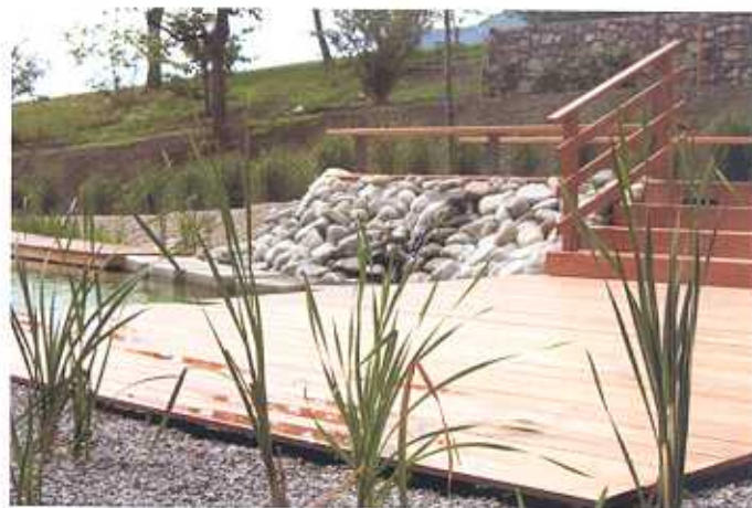
fig. 3.4.1: Piscina naturale senza muratura in cls
