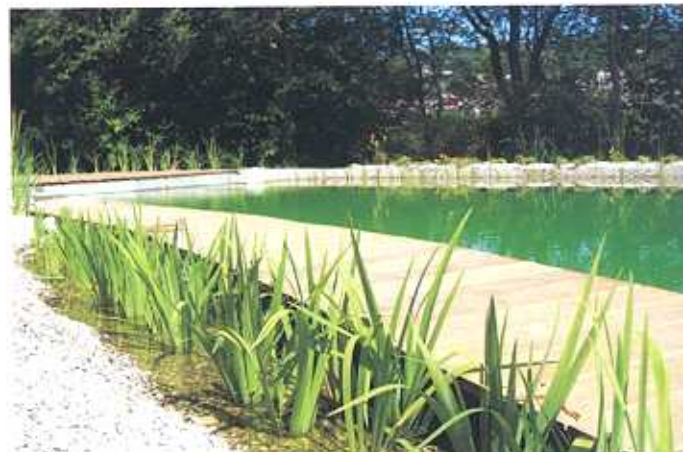
fig. 3.4.7: Piscina naturale senza muratura in cls
