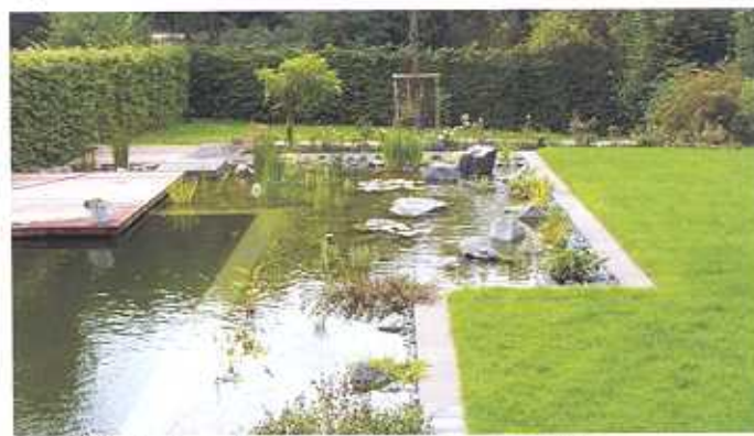
fig. 3.4.9: Piscina naturale con zona balneabile e di rigenerazione: formali realizzate in muratura sulle colline delle Langhe
