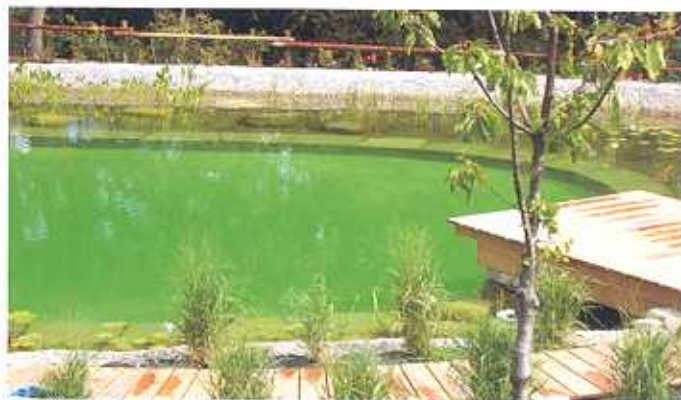
fig. 3.4.2: Piscina naturale senza muratura in cls
